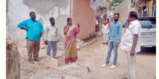
డ్రైనేజీ నిర్మాణ పనులను పరిశీలిస్తున్న మున్సిపల్ చైరపర్సన్ పాపనయాదవ్
